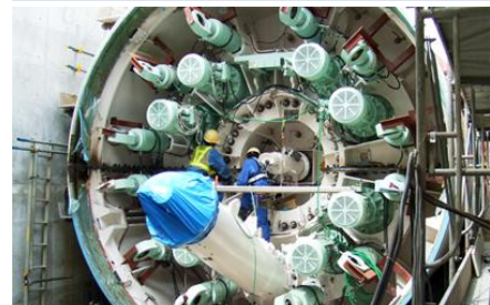
シールドマシン組立・据付け
