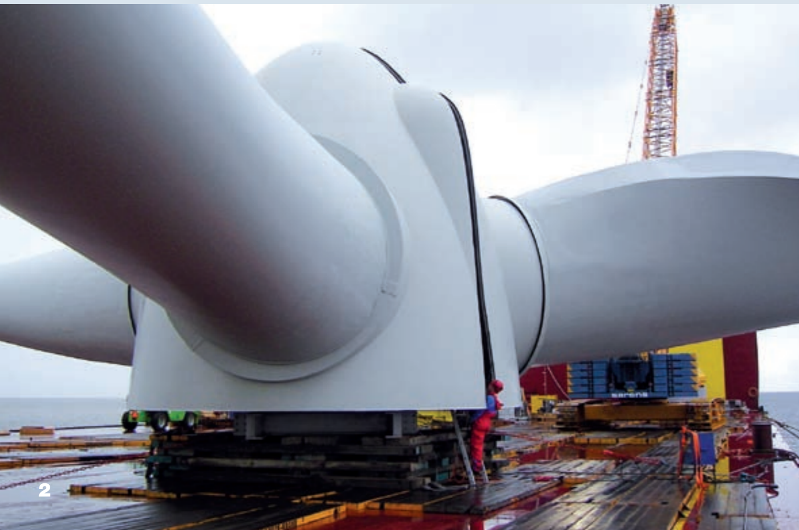
Die „Giant 4“ mit Mannschafts- und Werkzeugcontainern dient als Montageplattform und liegt vor Anker.
