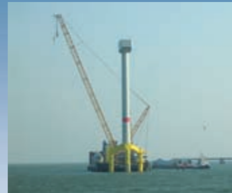
Das Stützkreuz (Triple genannt) mit Turm und Maschinenhaus ist schon montiert. Die Nabe auf der „Giant 4“ wartet auf ihre Blätter.
