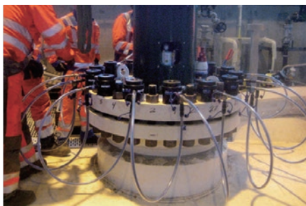
圧力容器のフランジボルトを同時に並行締め
